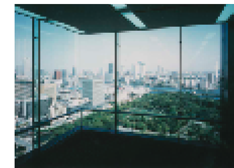
オフィスのコーナー部。隅には柱がなく視界が開ける。
