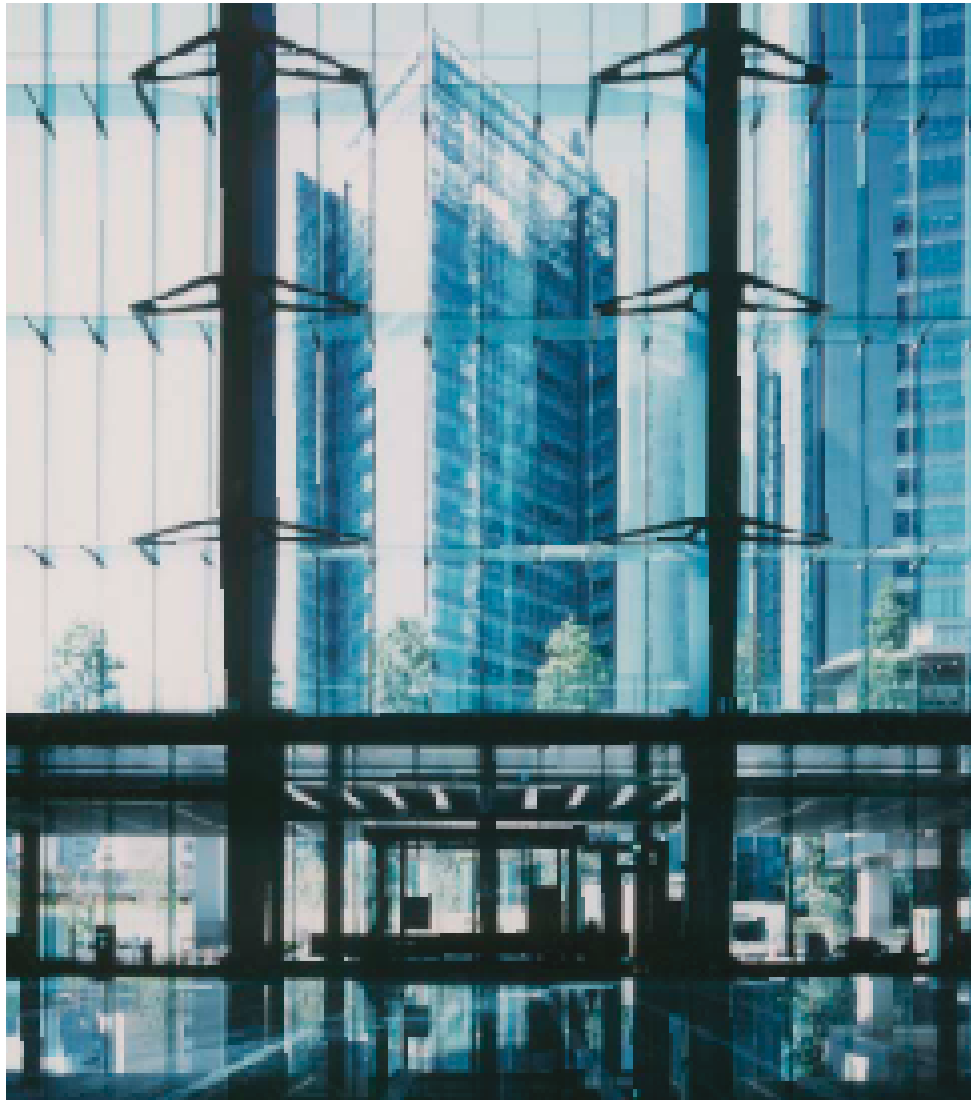
アトリウムエントランスのファサード内観。上に載るオフィス層を支える紡錘型の柱がファサードも支持する。
