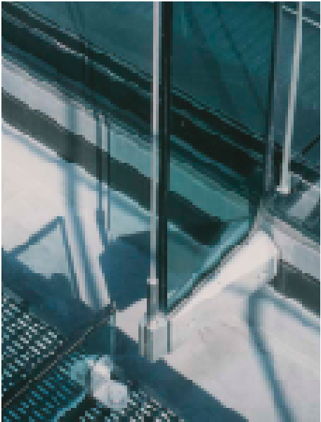
ファサード下端部分の「クロコダイル・ノード」
