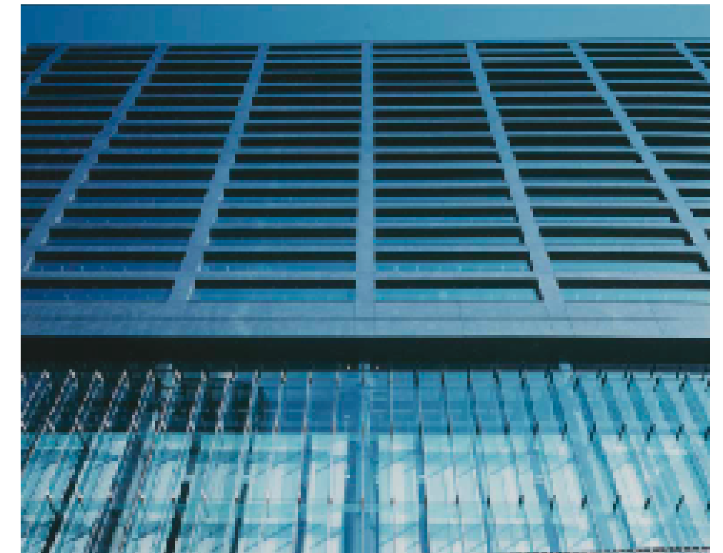
アトリウムエントランスとオフィスのファサードを見上げる。
