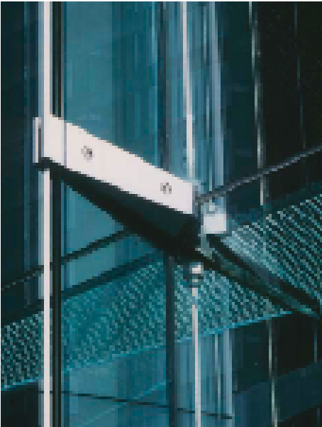
ファサードのジョイント金具「クロコダイル・ノード」
