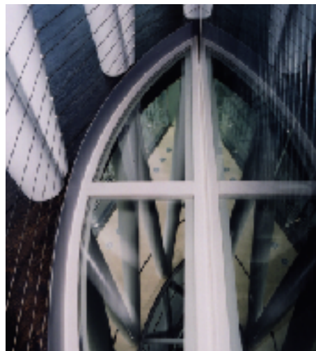
5階スラブ面に使われたパイロストップ photo by Iwata Hideaki
