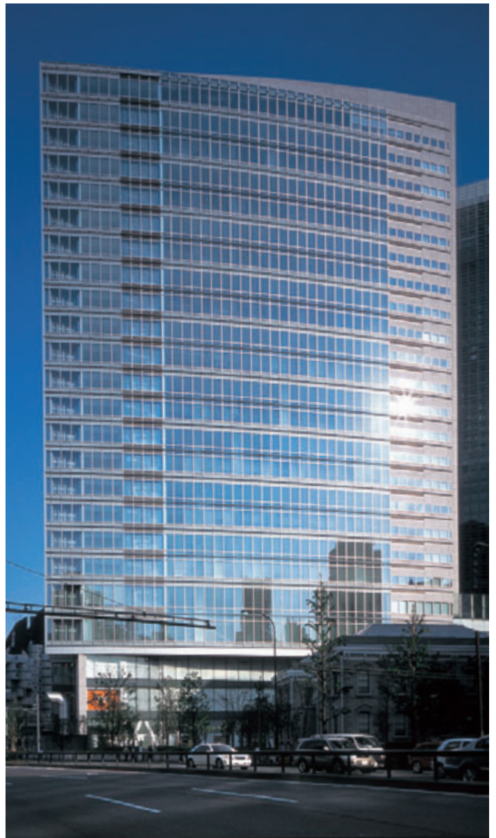
●パナソニック株式会社東京汐留ビル(東京) 設計:日本設計(建築・構造) 日建設計(設備) ペアマルチLow-Eクリアブルー 75
