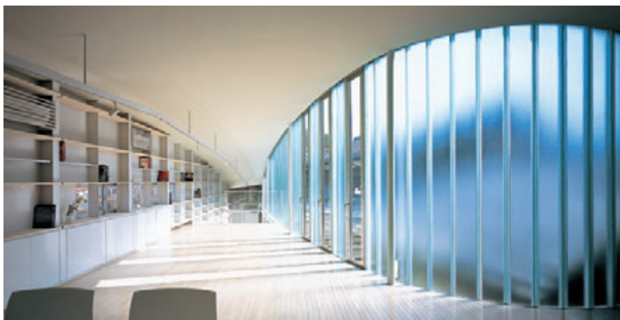
●メガタ(神奈川県) ▶ 設計:小泉雅生 C+A 施工:岩本組 プロフィリット
