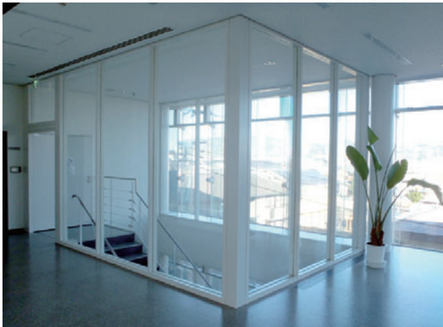
●JAかながわ西湘本店(神奈川) 設計:全農かながわ 施工:日本国土開発 使用ガラス:パイロストップ(スリムタイプ 1時間耐火間仕切壁)
